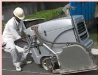
カッター工事
