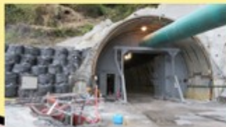
トンネル工事
