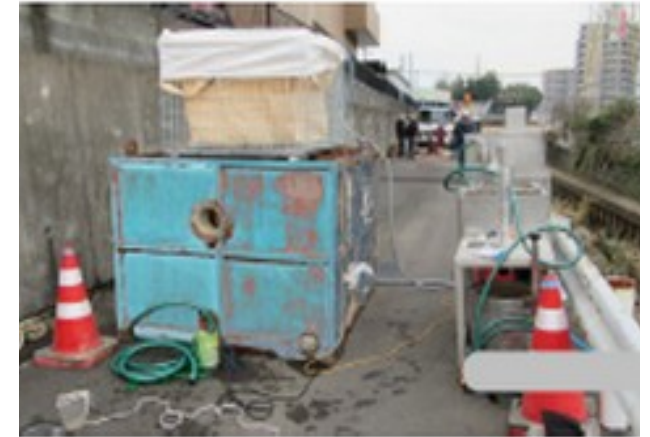
水槽と特殊フィルター
