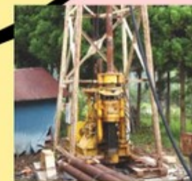
ボーリング工事
