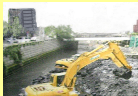
掘削工事の汚泥処理現場
