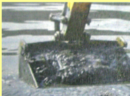
凝集した汚泥
