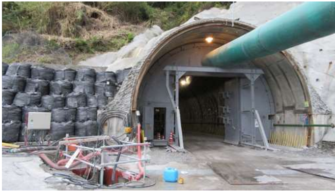
トンネル外観
